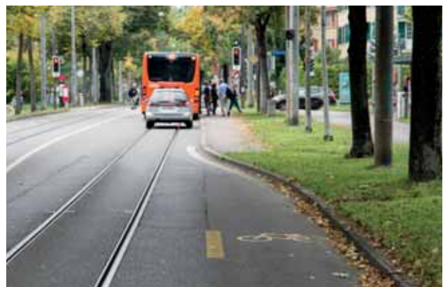
Weltpostverein, Bern. Hohe MIV-Belastung vorhanden, starker Versatz für den Veloverkehr, kein Fluchraum vorhanden.
