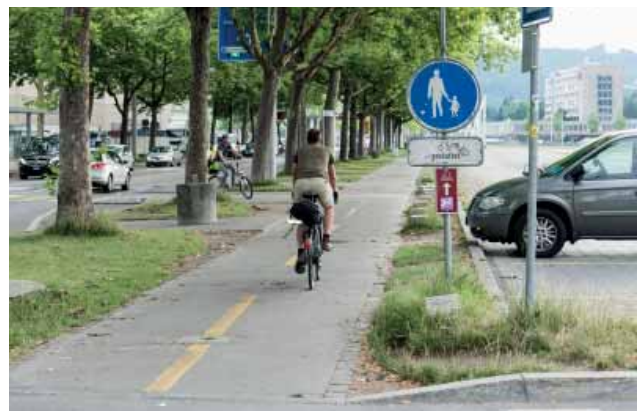
Entlang der Papiermühlestrasse ist es für den Veloverkehr zugelassen, den Fussweg zu benützen. Damit kann die stark belastete Strasse sowie die Kaphaltestelle umfahren werden. Die Ausführung entspricht nicht den Vorgaben des UHR (taktile Abgrenzung FG / Velo fehlt).
