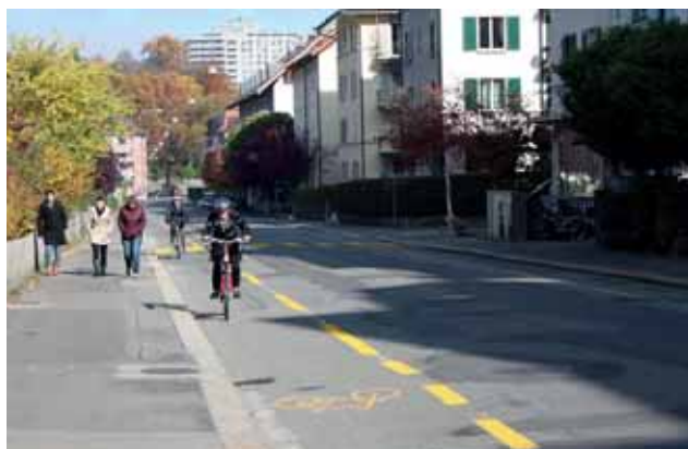
Kernfahrbahn anstelle Längsparkierung: Mehr Raum für den Veloverkehr, bessere Überholmöglichkeit für den ÖV. (Könizstrasse, Bern)
