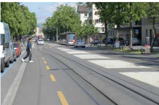
Funktionaler Mehrzweckstreifen durch farblich gestaltete Strassenoberfläche, wird heute nicht mehr so realisiert, da die Ausführung nicht den Vorgaben zur Umsetzung eines hindernisfreien öffentlichen Raumes (UHR) entspricht. Schlossstrasse, Bern.
