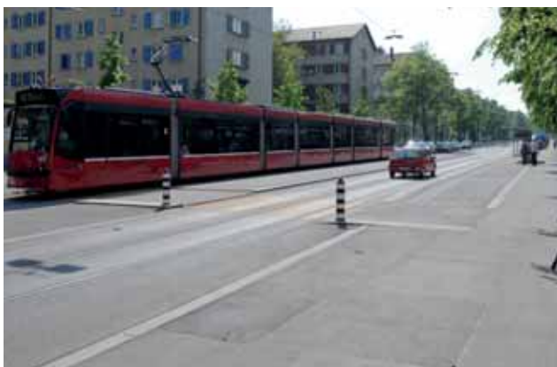
Schlossmatte, Bern. Vergleichsweise tiefe MIV-Belastung, Kapvorsprung mit niedrigem Randabschluss, so dass ein Fluchraum für Veloverkehr erreichbar ist.
