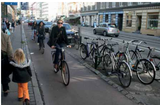
Best-Practice aus Dänemark (und Holland): Der abgesetzte Radweg hinter den Parkplätzen (oder Baumreihen). Zur Fahrbahn besteht damit ein baulicher Schutz, ein- und ausparkierende Autos müssen den Radweg nicht befahren.
