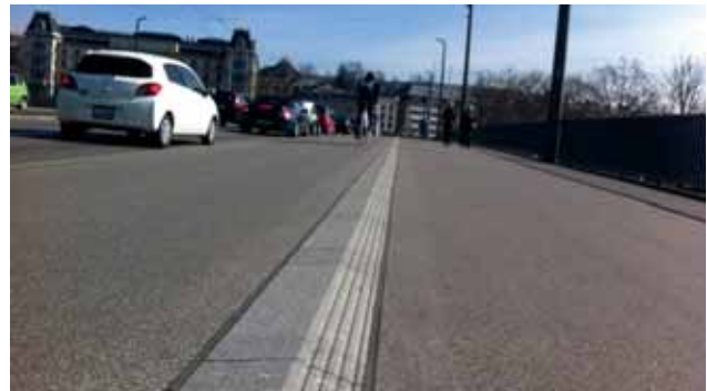
Trennung Fuss- und Veloverkehr Quai-Brücke, Zürich (Bild: Florian Boller)
