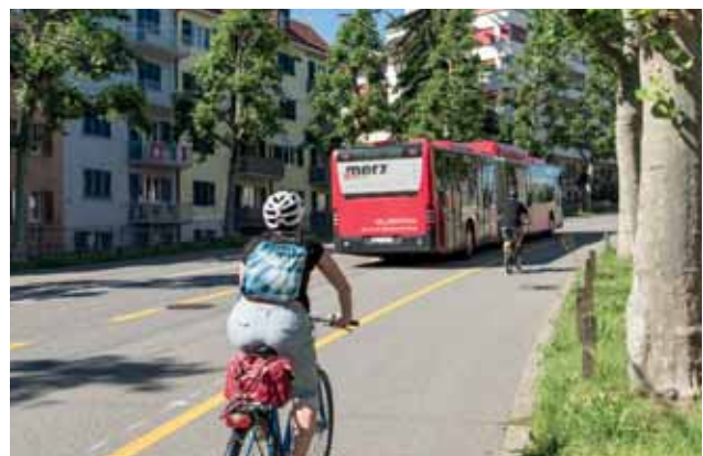
Ununterbrochener und breiter Radstreifen ( 2.25 m) bei der Steigung zur Wyleregg. Überholen ist innerhalb des Radstreifens möglich und zum Bus besteht ein ausreichender Sicherheitsabstand.
