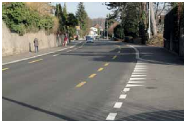
Ortsdurchfahrt Muri bei Bern. Auf der rund 8.00 m breiten Strasse wechseln sich Radstreifen und Mittelinseln für den Fussverkehr ab. Für den Veloverkehr stellt dies bei einem DTV von ca. 7'400 nicht den Idealfall dar, ist aber in Abwägung aller Interessen vertretbar.
