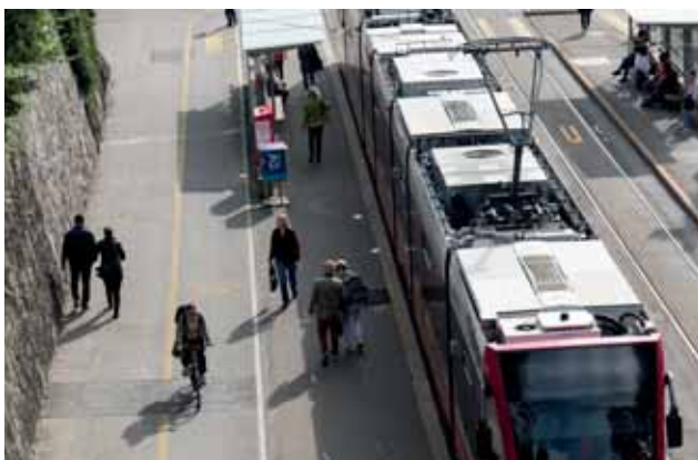
Kursaal, Bern. Die Platzverhältnisse sind ausreichend, die Ausführung entspricht nicht den Vorgaben des UHR (taktile Abgrenzung FG / Velo fehlt).
