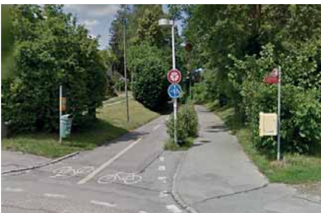
Radweg Wabern-Schönausteg: Aufgrund der Längsneigung ist hier eine Trennung zum Fussverkehr sinnvoll.
