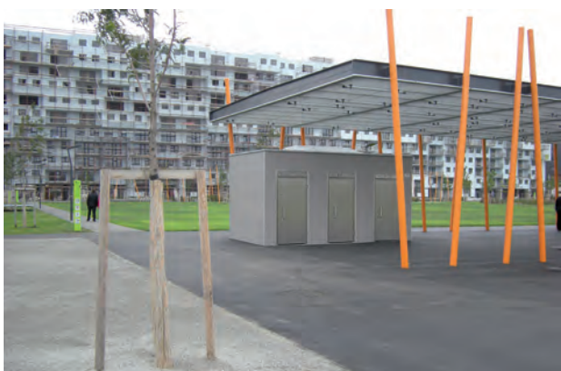
Öffentliche Toilettenanlage im Park
