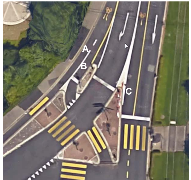
Fig. 3 : Carrefour à Bâle avec un bypass (A), un tourner-à-gauche indirect (B) pour les cyclistes peu expérimentés et liaison directe pour cyclistes ayant l'habitude (C) (Photo aérienne: Google)
