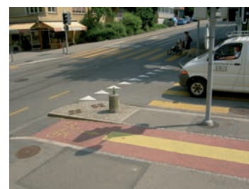
Zürich, Kreuzung Klosbach- / Freiestrasse: In der Fortsetzung des Zebrastreifens ist ein Balken über den Radweg gelegt. Die FussgängerInnen haben bei der Querung des Radweges Vortritt.
