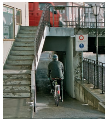
Thun: Engstelle, die sich nicht als gemeinsame Fläche eignet. Hier müsste das Signal «Velo schieben» angebracht werden.
