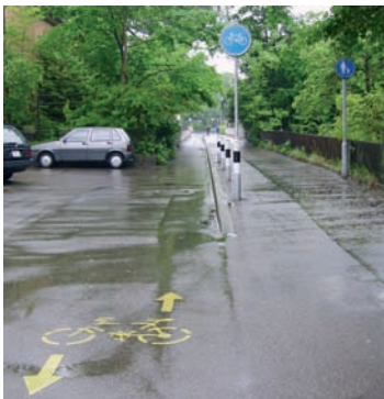
Zürich, Birchsteg: Getrennter Fuss- und Radweg. Das Regime wird baulich (Absatz zwischen den beiden Bereichen) sowie mittels Signalisation und Markierung verdeutlicht.
