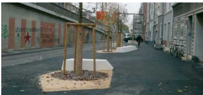
Grosszügige, mit Bäumen und Sitzgelegenheiten ausgestattete Aufenthaltsflächen verten die Quartierstrasse für den Fussverkehr auf.
