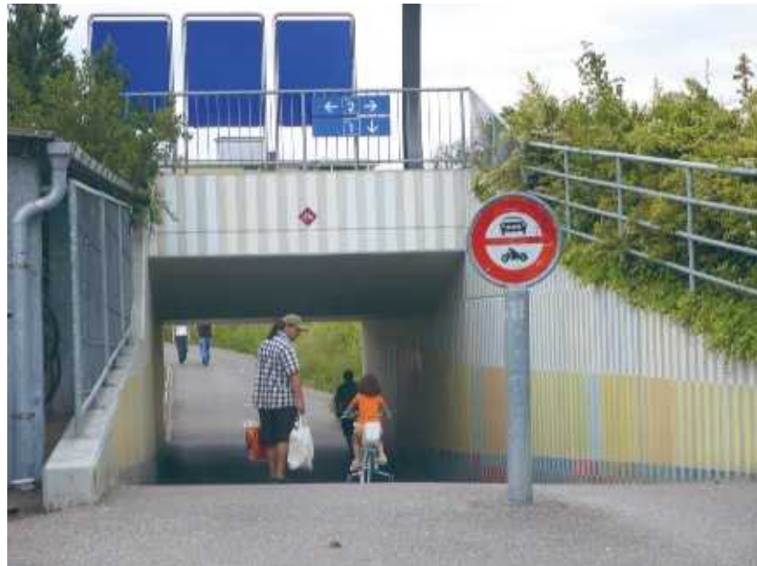
Die geradlinig geführte Unterführung ist gut einsehbar.
