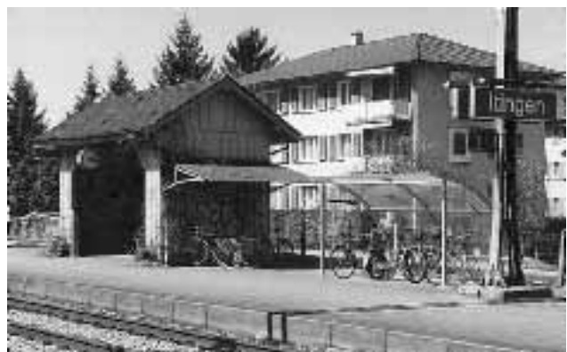
Diese Anlage ist perronnah und gut einsehbar
