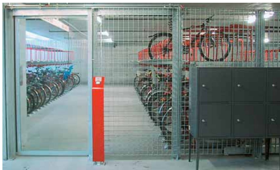
Im Velo-Parking Biel kann das Velo über ein elektronisches Zutrittssystem für 1 Franken einen Tag abgestellt werden.
