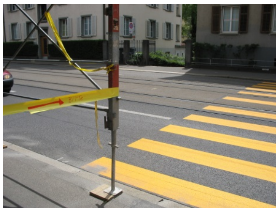
Verbesserungswürdig: Eine solch behelfsmässige Wegweisung ist unbrauchbar. (Bild: Zürich)
