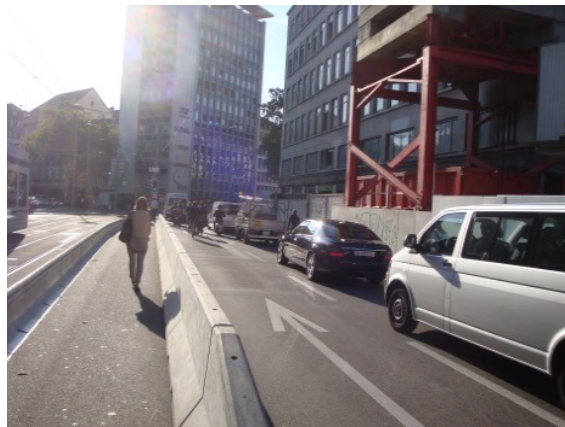
Vorbildlich: Die Fusswegumleitung ist dank stabilen Betonelementen gesichert. (Bild: Zürich)
