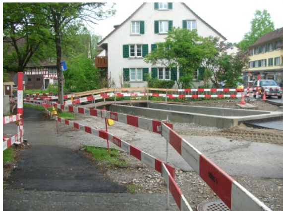
Vorbildlich: Mit Belagseinbau und Fusssteg wurde eine behindertengerechte temporäre Wegführung realisiert. (Bild: Bassersdorf)
