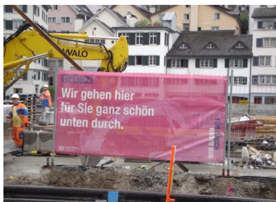
Vorbildlich: Begleitend zur Baustelle wird eine Informationskampagne durchgeführt. (Bild: Zürich)
