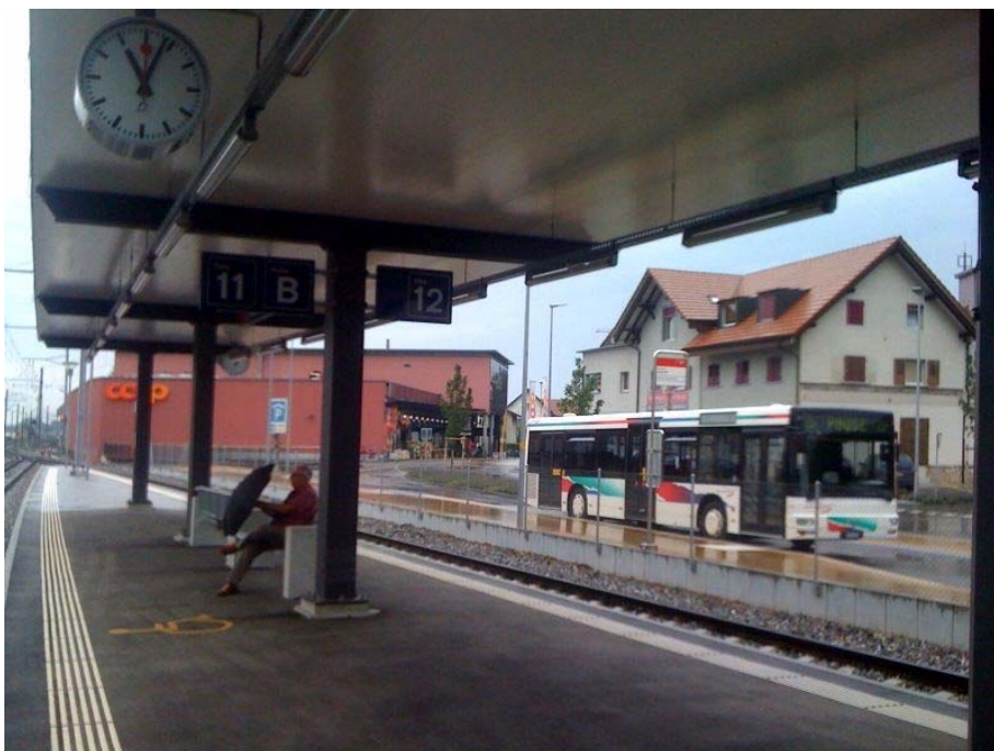
Bahnstation Niederbipp (Quelle: Kanton Solothurn, AVT)
