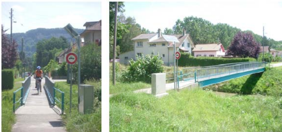
Bild 1: Zählstelle Yvonand VD (Zählschrank mit Solarpanel)
