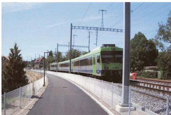
Voie aménagée sur le tronçon ouest parallèle à la ligne BLS (source: ville de Berthoud)
