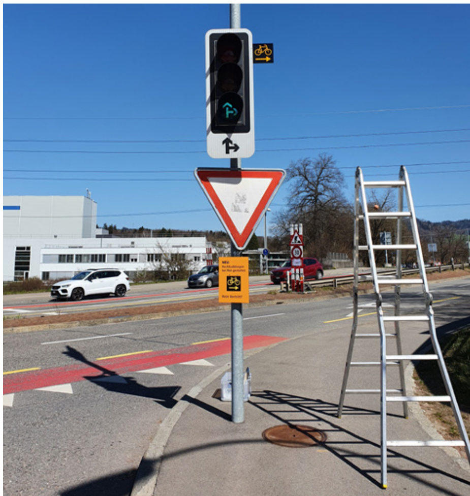
Mise en place du tourner-à-droite au feu rouge (photo: Office des ponts et chaussées de la ville de Berne)
