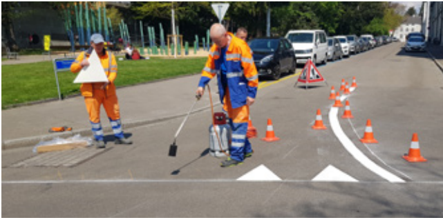
Travaux de marquage au sol au Schaffhauserheinweg
