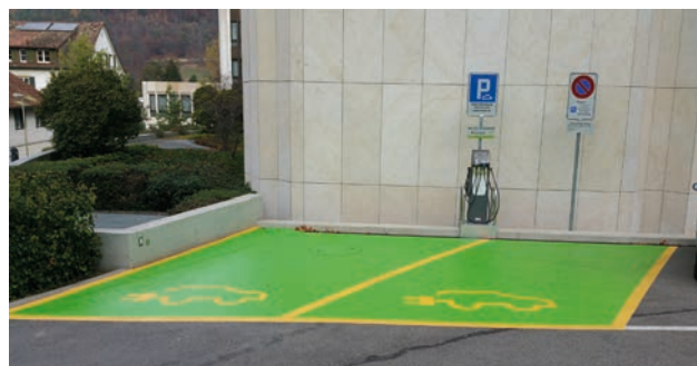
Figure 37 : exemple de signalisation horizontale et verticale pour place de parking réservée à la recharge de véhicules électriques. Les indications complémentaires sont à adapter au contexte du parking.
