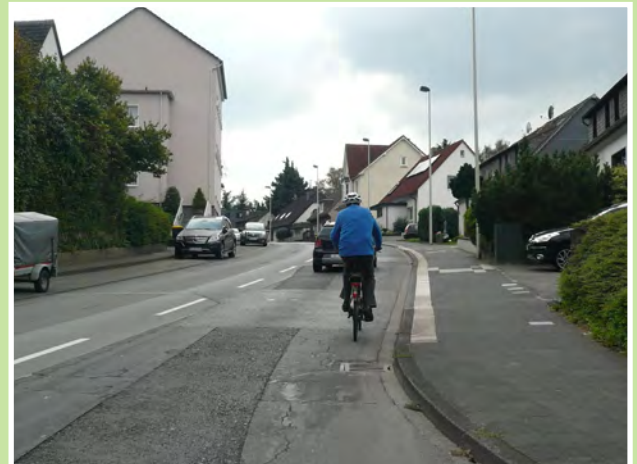
Abb. 18: Straßenzug vor und nach Sanierungsarbeiten – Markierung eines Schutzstreifens im Rahmen einer Sowieso-Maßnahme
