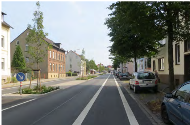
Abb. 9: Gemeinsamer Geh- und Radweg
