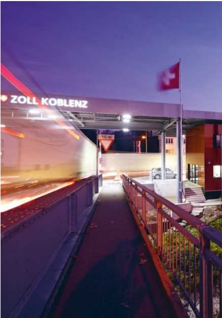
Il nuovo edificio della dogana al valico di confine Coblenza-Waldshut
