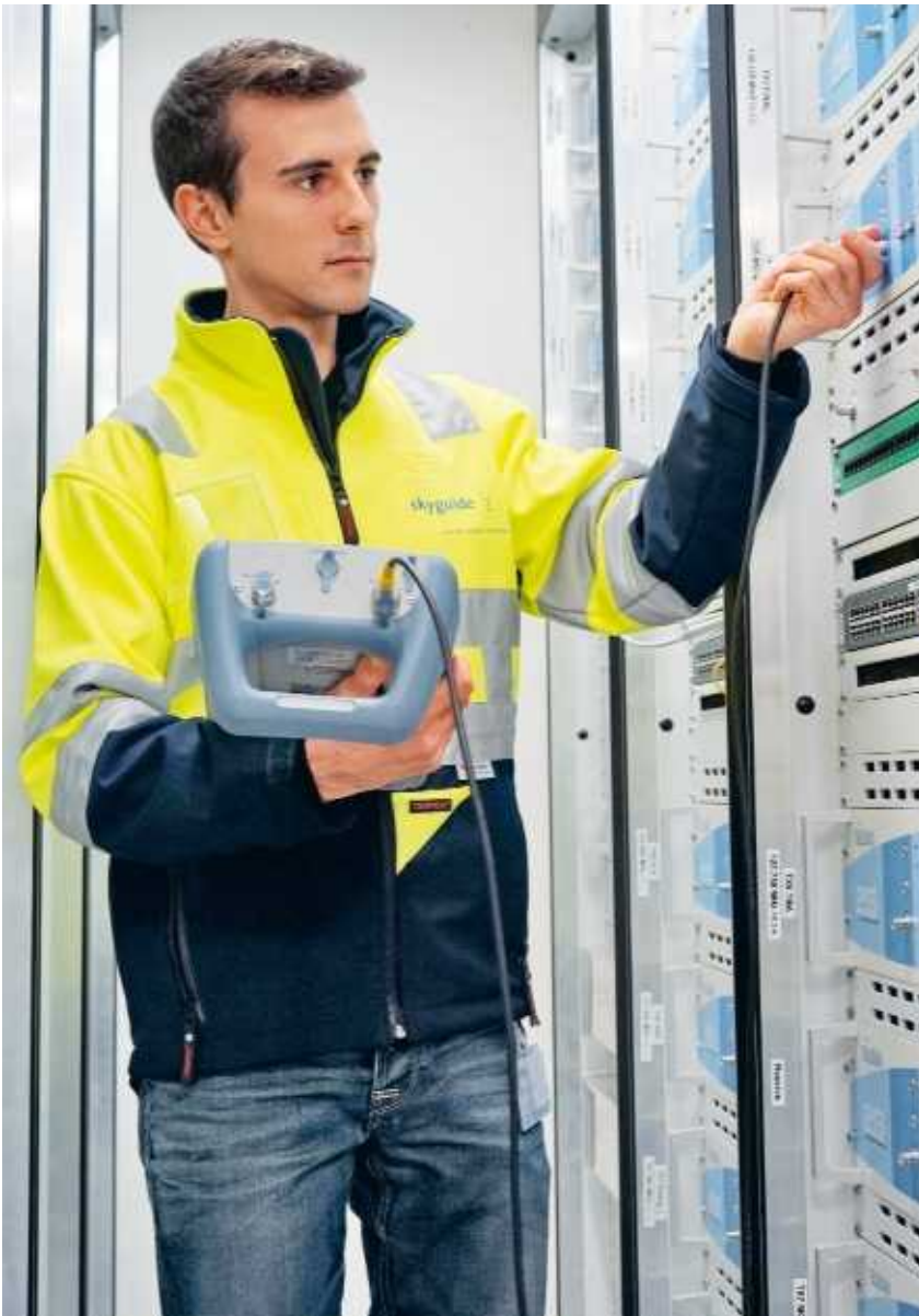
Technicien présent sur l'une des nouvelles stations radiophoniques
