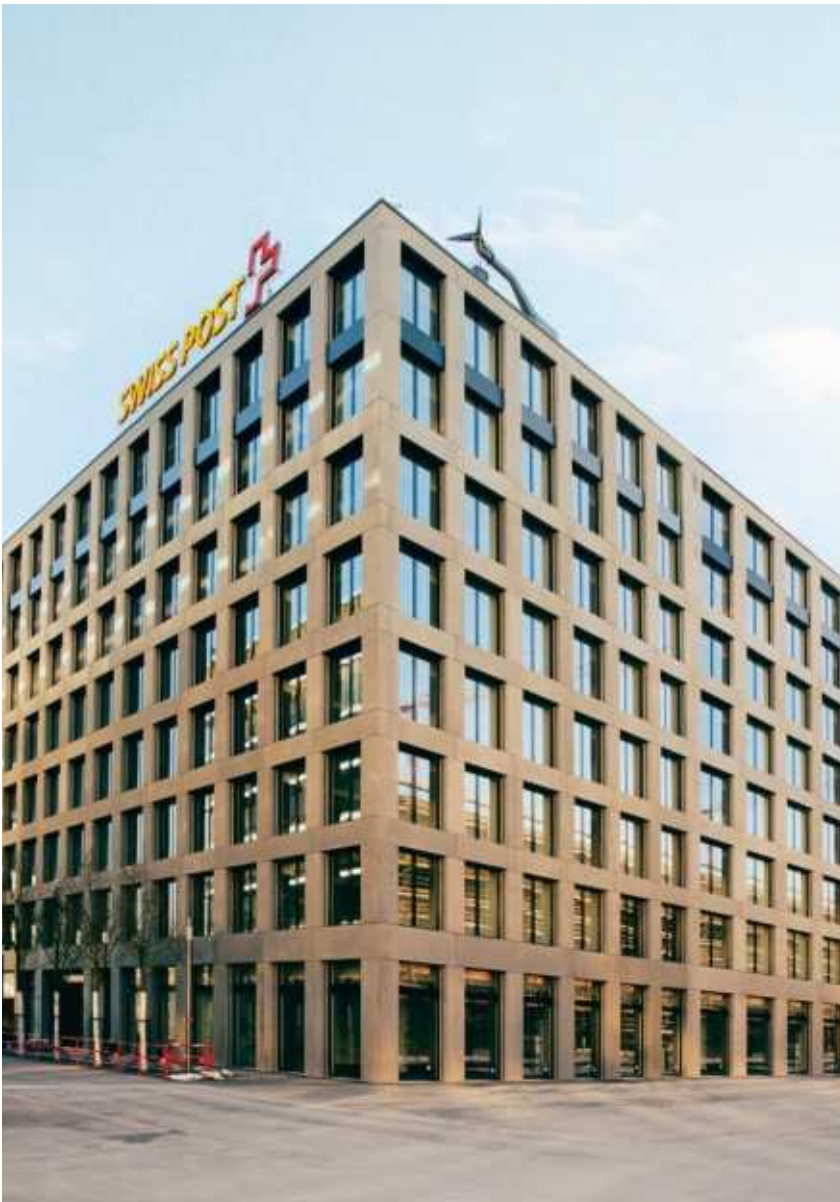
Le nouveau siège principal de la Poste, à Berne, dans le quartier du Wankdorf
