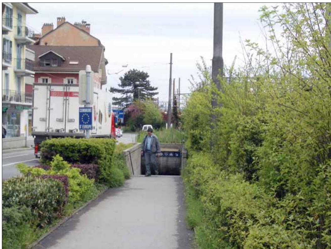
Vue d'un des accès à la gare, côté nord
