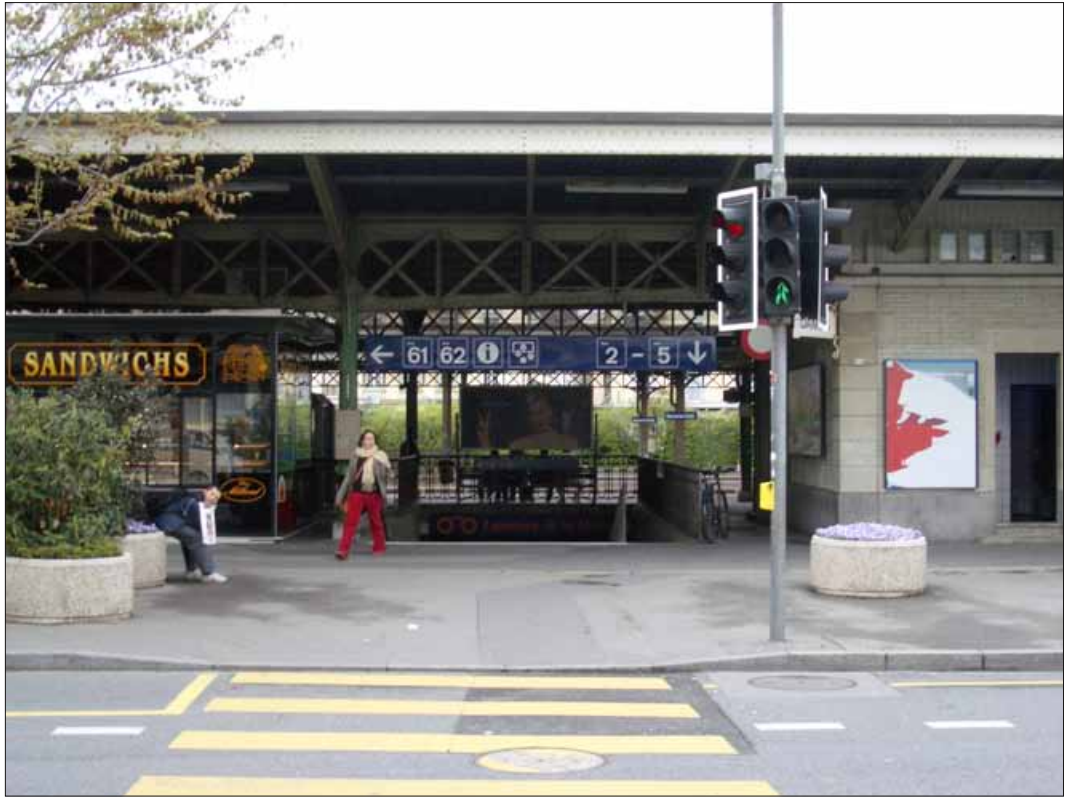
Vue de l'accès au passage inférieur, côté sud
