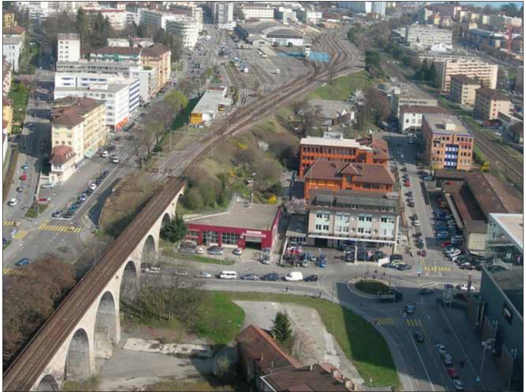
Vue de la RC 151, du Pont du Gallicien et de l'Avenue du Chablais, côté nord
