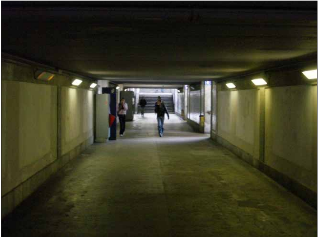
Vue de l'unique passage inférieur de la gare de Renens
