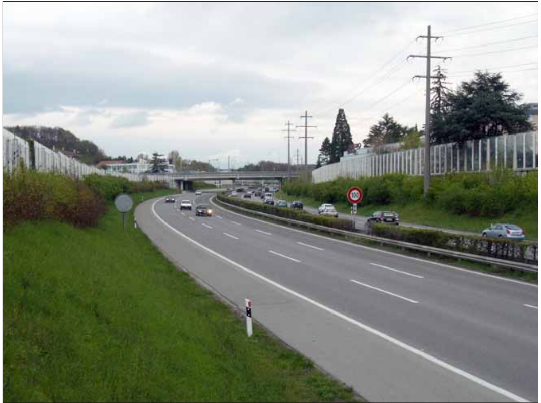
Vue de l'autoroute à franchir
