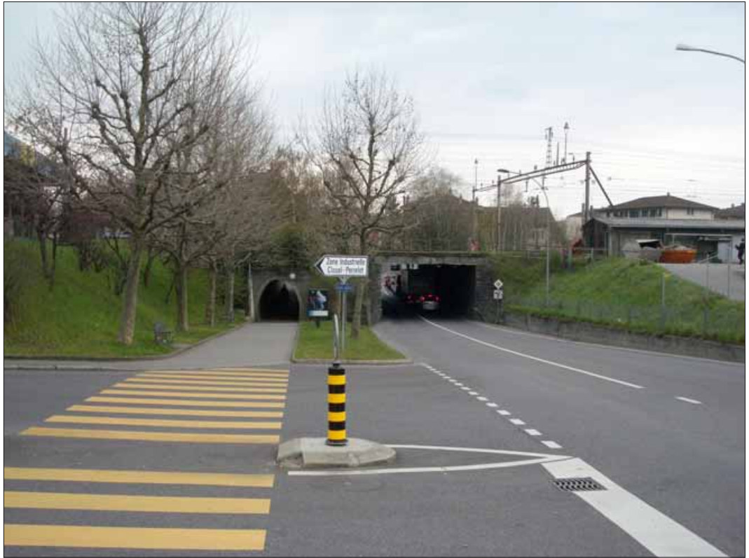
Vue de l'Avenue du Léman, côté nord des voies CFF
