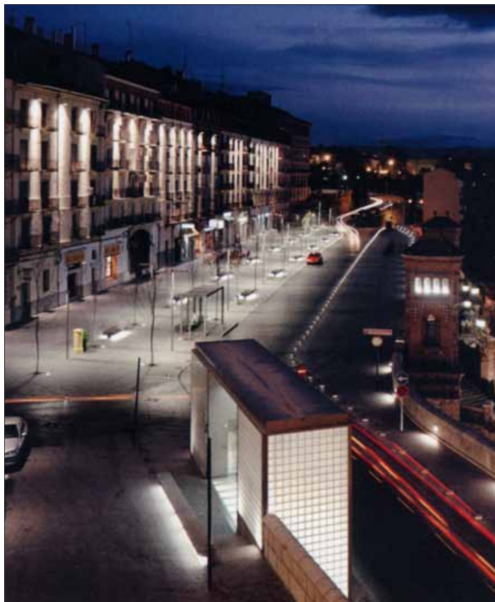
Mise en lumière de l'espace public Teruel, Espagne
