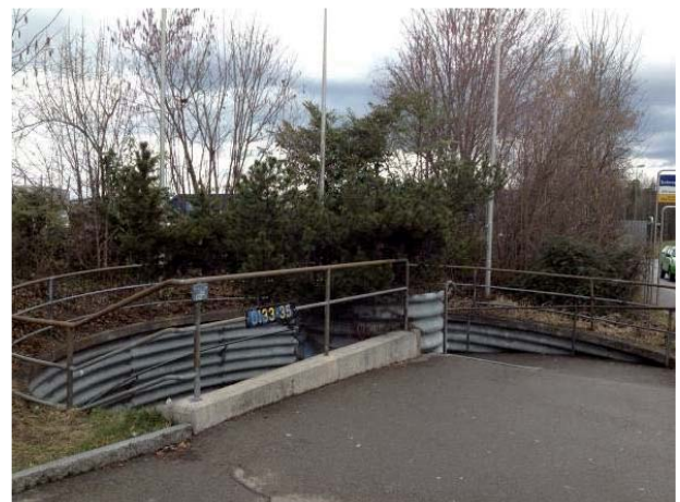
Verständlichkeit, Zugänglichkeit, und Aufenthaltsqualität an den Haltestellen sollte verbessert werden: Haltestelle Schnegg an der Zugerstrasse.
