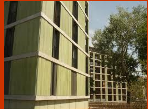
Foyer de Sécheron (2010)
