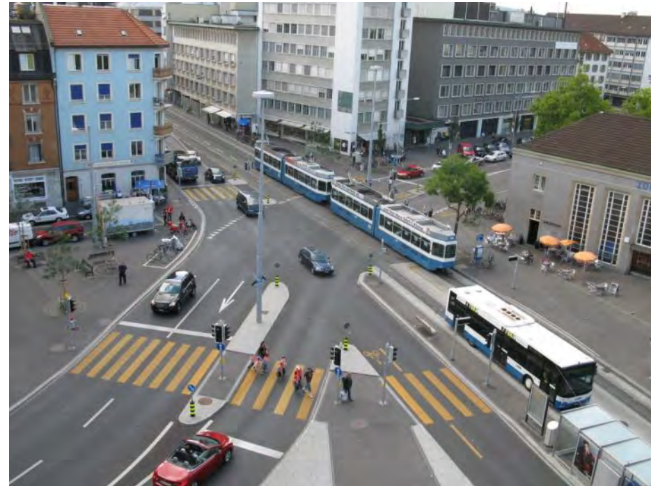
Knoten Schimmel-/Birmensdorferstrasse, August 2011: Gegenverkehr, Verlagerung Transitverkehr auf Westumfahrung, in der Birmensdorferstrasse Aufhebung eines MIV-Fahstreifens zugunsten Velostreifen und breiteren Trottoirs
