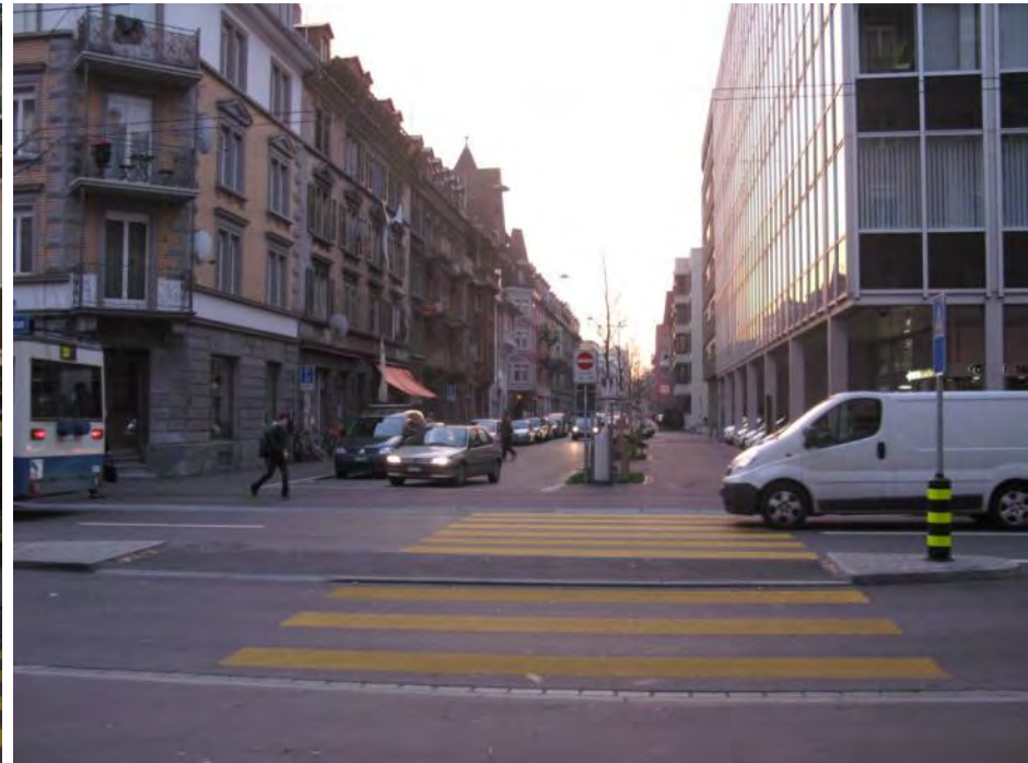
Weststrasse (Kreuzung West-/Kalkbreitestrasse), November 2012: Umbau zu einem Knoten ohne Lichtsignalanlage, Einmündung Weststrasse als Trottoirüberfahrt, Umbau zu verkehrsberuhigter Quartierstrasse mit Tempo 30, neue Gestaltung mit Baumreihe und Parkfeldern
