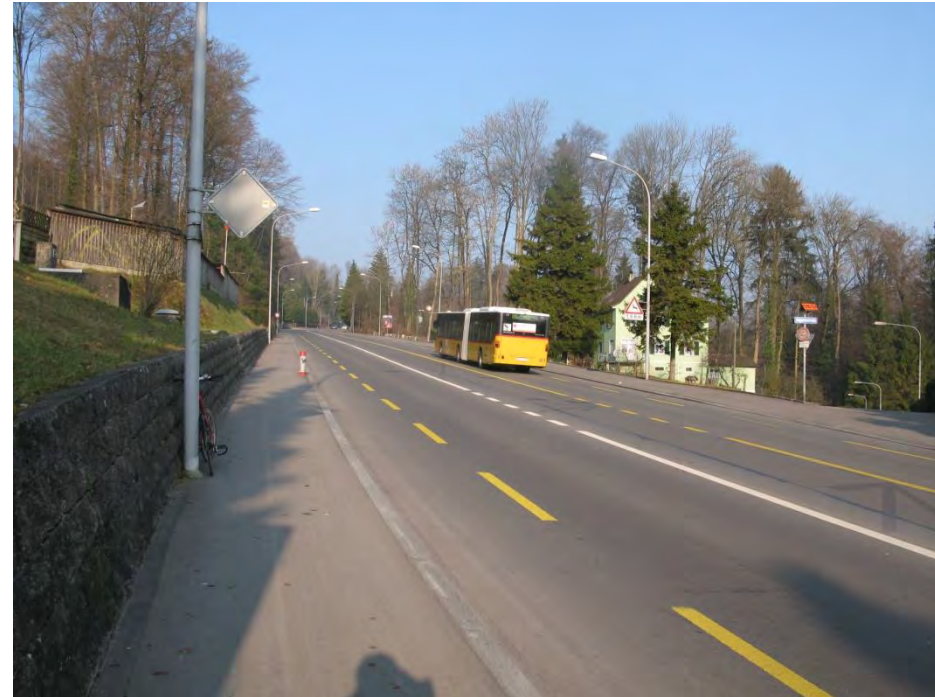
Birmensdorferstrasse, März 2014: Neuaufteilung des Fahrbahnquerschnitts zugunsten einer Busspur und eines Velostreifens Fahrtrichtung Waldegg
