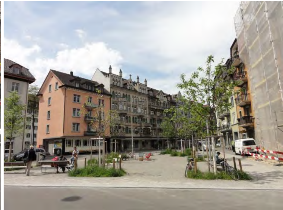
Brupbacherplatz, Mai 2013: Umbau der Strassenkreuzung West-/Gertrudstrasse zu einem Platz, Wegfall der Fahrbahn auf der Ostseite, neue Gestaltung mit Bäumen und Bänken
