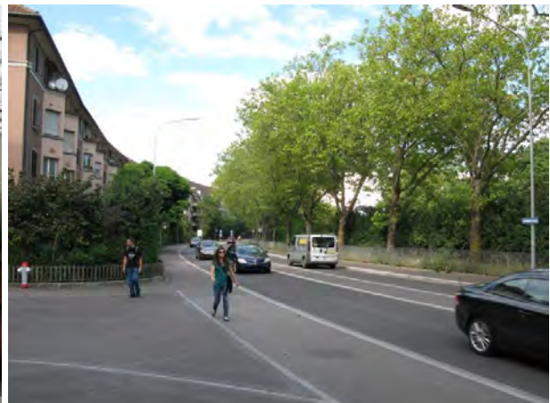
Seebahnstrasse nach dem Umbau (2012): innerstädtische Hauptverkehrsstrasse, Gegenverkehr mit Mittelstreifen, Verlagerung Transitverkehr auf Westumfahrung
