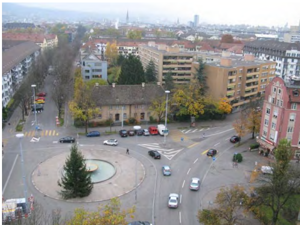
Bullingerplatz vor dem Umbau (2008)
