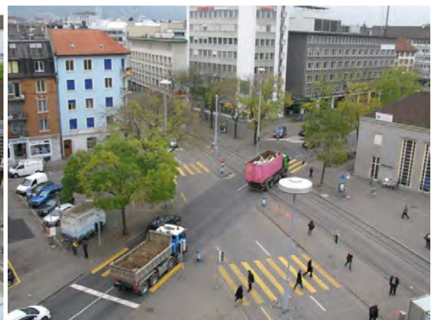
Knoten Schimmel-/Birmensdorferstrasse nach dem Umbau (2011): Gegenverkehr, Aufhebung MIV-Fahrstreifen, breitere Trottoirs
