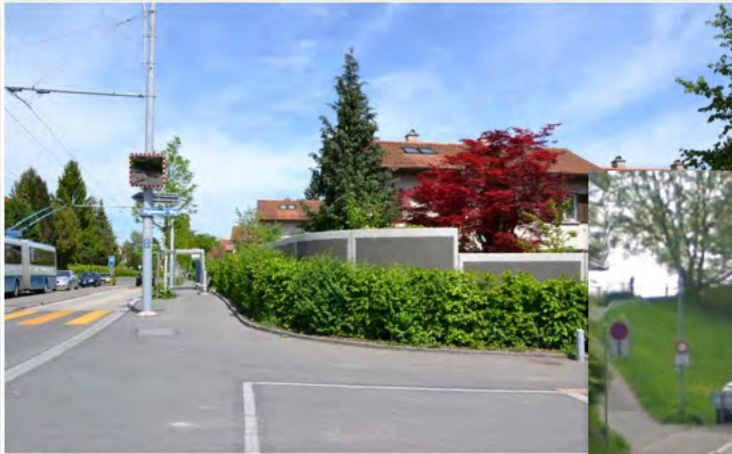
Abb. 1 Lärmschutzwand an der Schweighofstrasse
