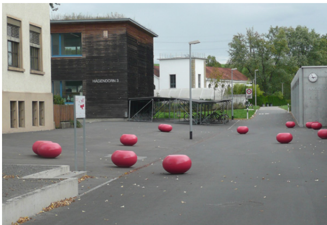
Abb. 5: Begegnungszone beim Schulhaus Hagendorn Cham Hier wurde zwecks besserer Wahrnehmung der Begegnungszone durch Fahrzeuglenkende eine einheitliche Fläche gestaltet, ohne einen Fahrbahnbereich zu unterscheiden.
