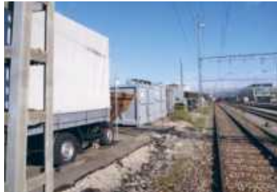
Eine Fusswegverbindung entlang der Geleise fehlt.
