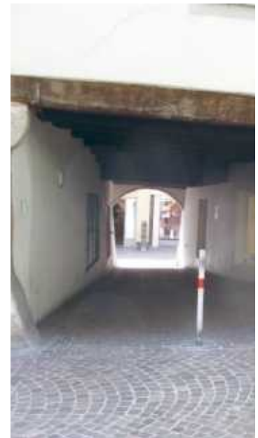
Der öffentliche Durchgang durch das Gebäude ermöglicht eine willkommene Abkürzung.
