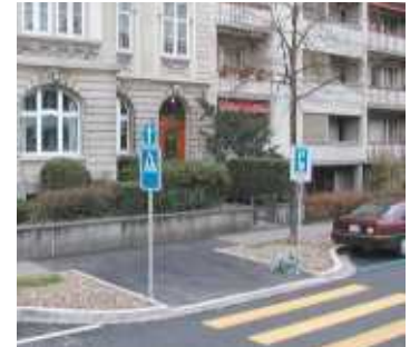
Seitliche Einengung (Trottoirnase)
